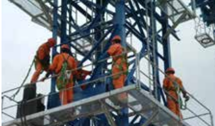
塔机顶升施工现场
